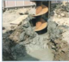
地盤改良・杭打ち泥土
