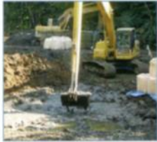
ため池増積土
